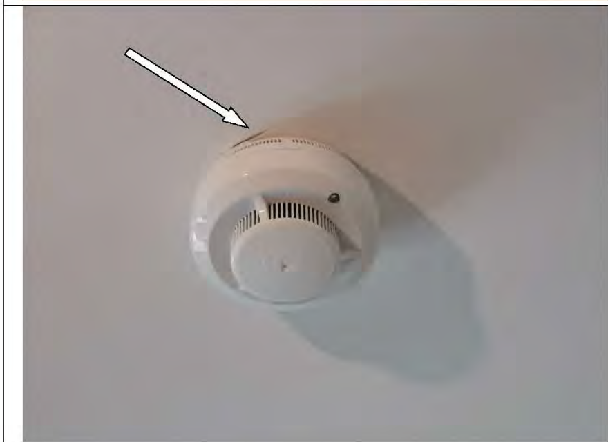
Фото №33. Царапины на поверхности окрашенного потолка в кухне.
