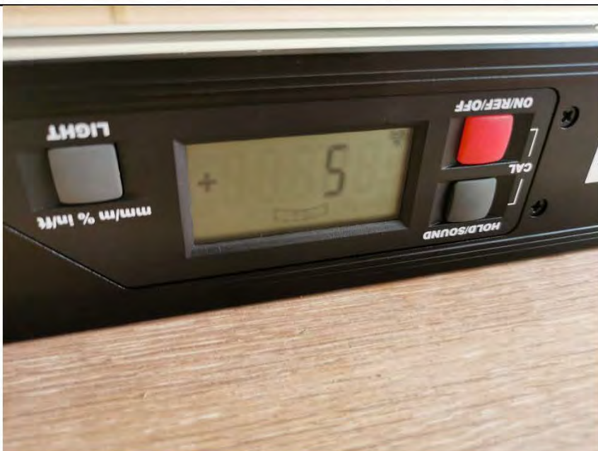
Фото №20. Измерение уровня пола в спальне.
