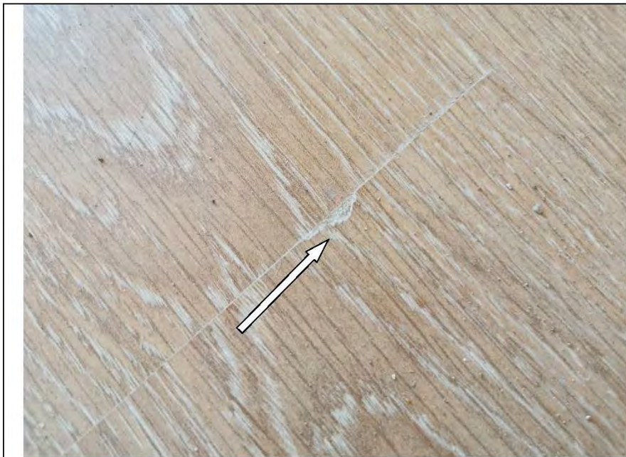
Фото №25. Скол на поверхности ламината в коридоре.
