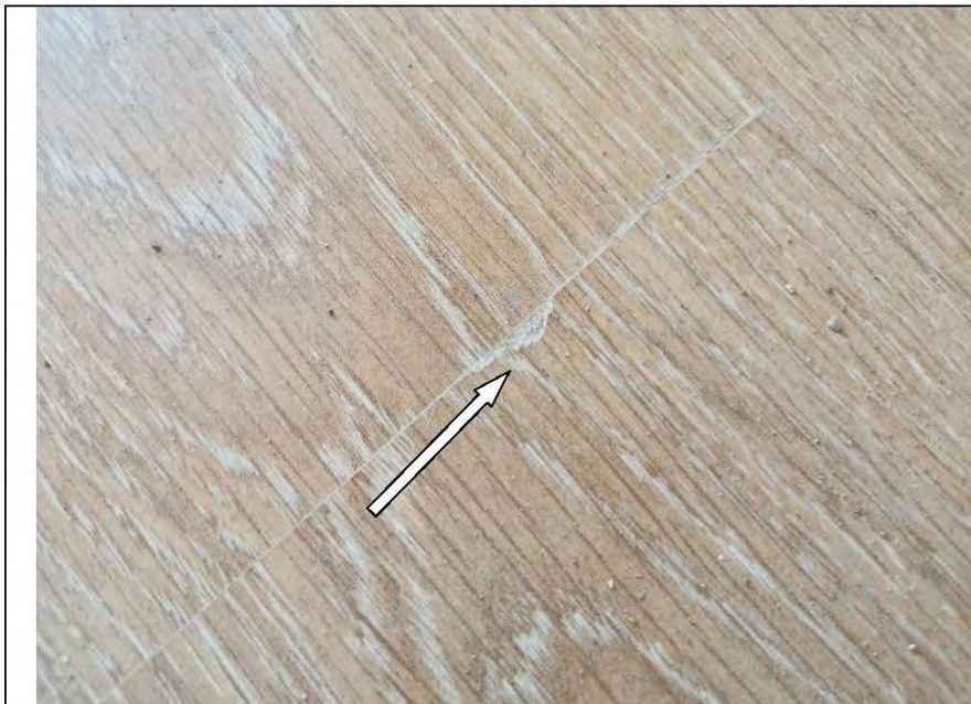
Фото №25. Скол на поверхности ламината в коридоре.
