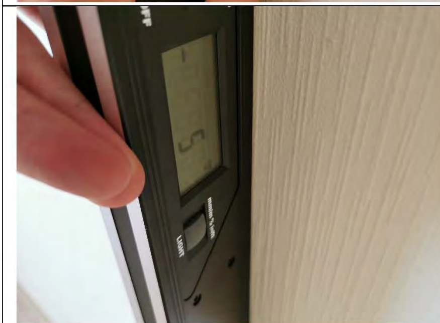
Фото №9. Измерение уровня стен в спальне.
