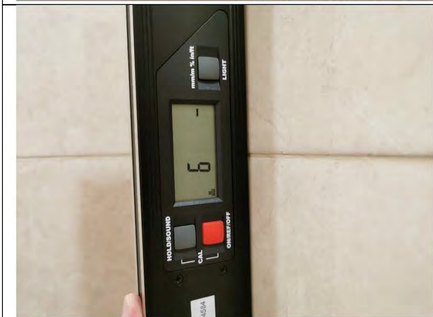
Фото №15. Измерение уровня стен в санузле.
