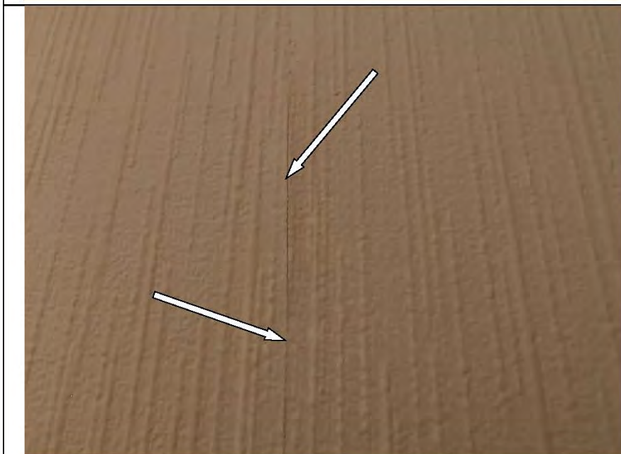
Фото №11. Читаемые обойные стыки в коридоре.
