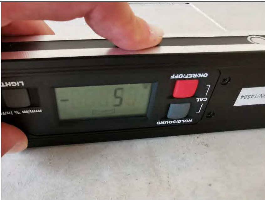
Фото №22. Измерение уровня пола в кухне.
