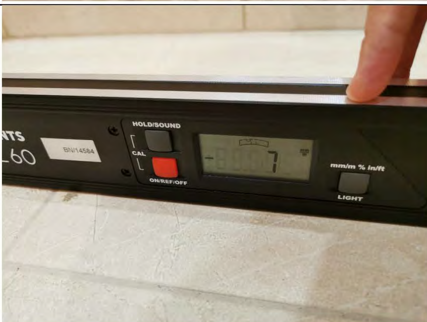
Фото №21. Измерение уровня пола в санузле.
