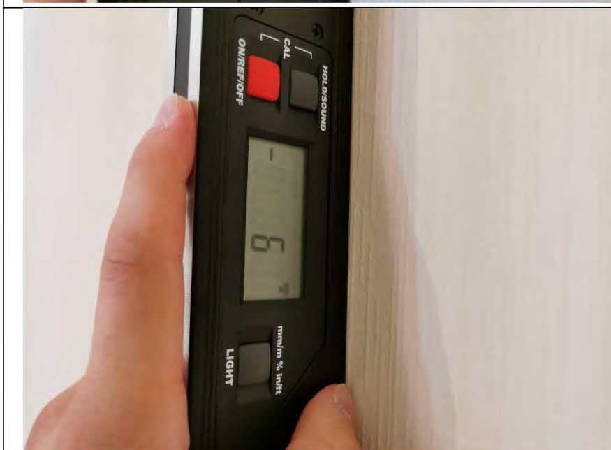
Фото №8. Измерение уровня стен в кухне.
